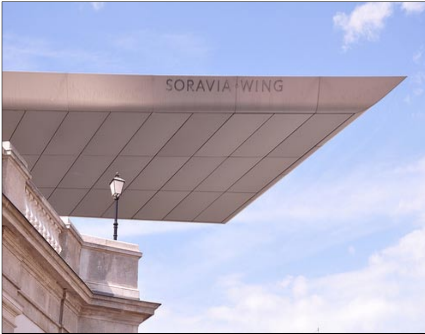
SORAVIA WING: Hinweis auf die Stifter am Dach Eingang zum Museum Albertina zu Wien, dem früheren Palais Erzherzog Albrecht. Foto: Helmut Flatscher
