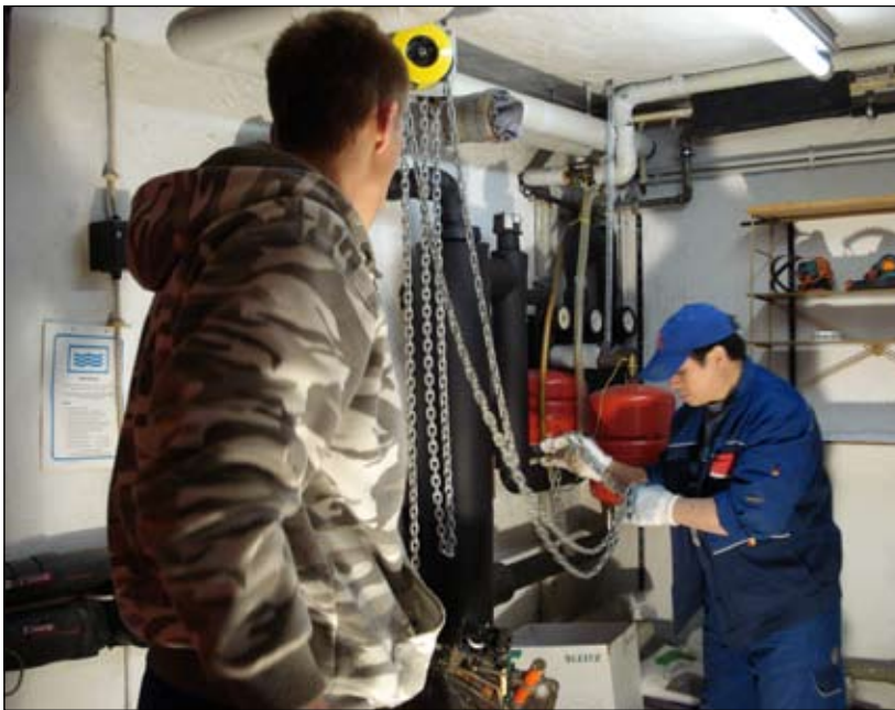
Gute Fachleute für Heizung und Sanitär sind beim Einbau energiesparender Anlage gefragt. Die gesetzlichen Auflagen für Altbauten sorgen auf Jahre hin für gute Beschäftigungschancen. Diese Berufe bieten ein hohes Maß an Vielseitigkeit und Abwechslung.
