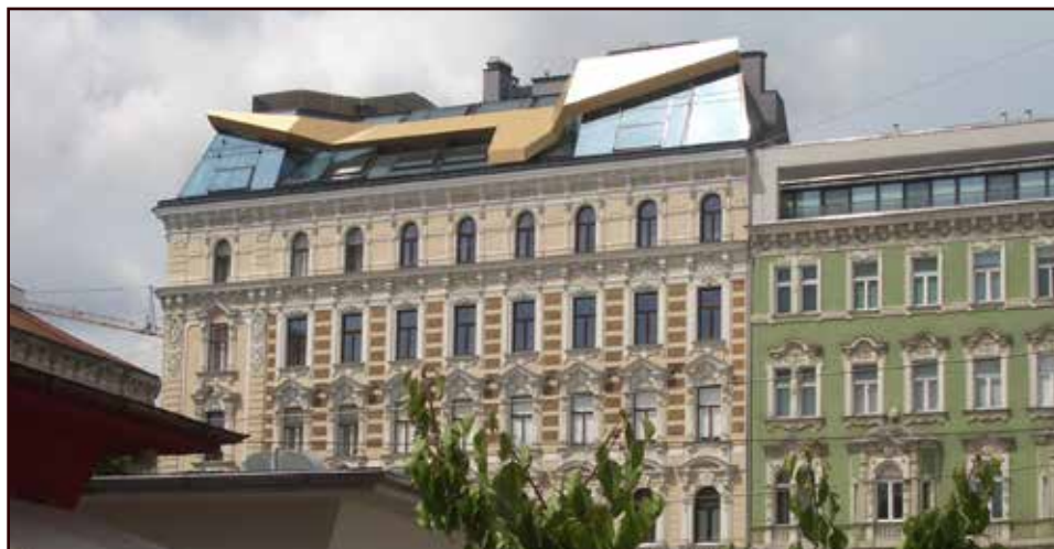
Bausünde – Zwei unterschiedliche Beispiele zeigen nachträglich aufgesetzte Dachwohnungen ohne Rücksicht auf die historischen Fassaden.
