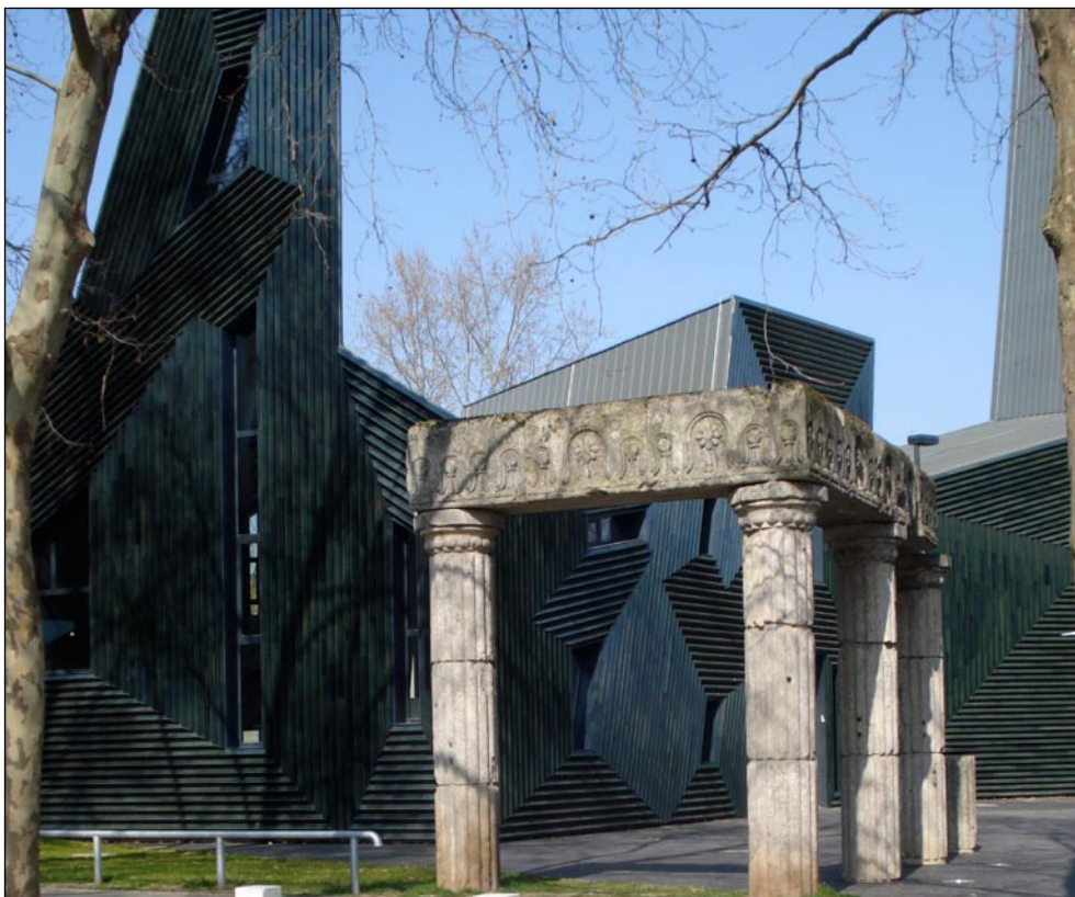
RESTE DER ALTEN SYNAGOGES VOR DEM NEUBAU: Die Säulen mit dem Relieffband sind die spärlichen Reste von authentischer Bausubstanz in Mainz.
