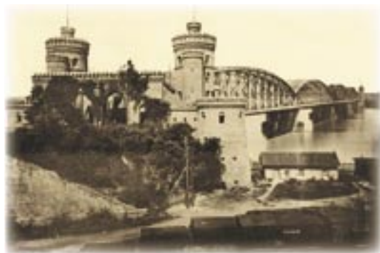
Die Rheinbrücke im Süden von Mainz wurde 1860 bis 1862 von MAN erbaut.
