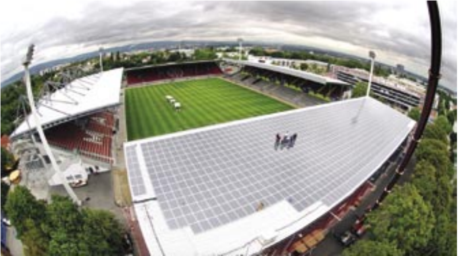
Solaranlage auf dem Bruchweg-Stadion des 1. FSV Mainz 05: Auf der Südtribüne errichtete die juwi GmbH die mit 240 Kilowatt bundesweit größte PV-Anlage in einer Sportarena.
